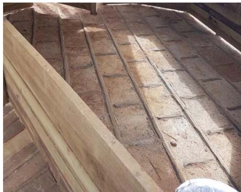
Figura 8 - Piso do centro de manejo em concreto armado
