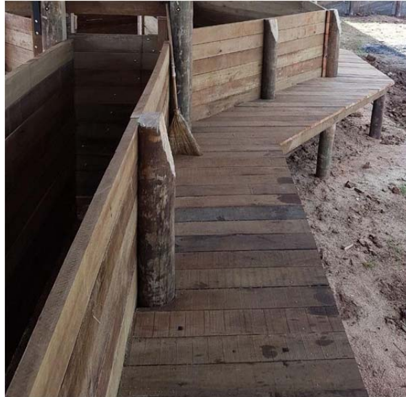
Figura 9 - Exemplo de passarela a ser executada
