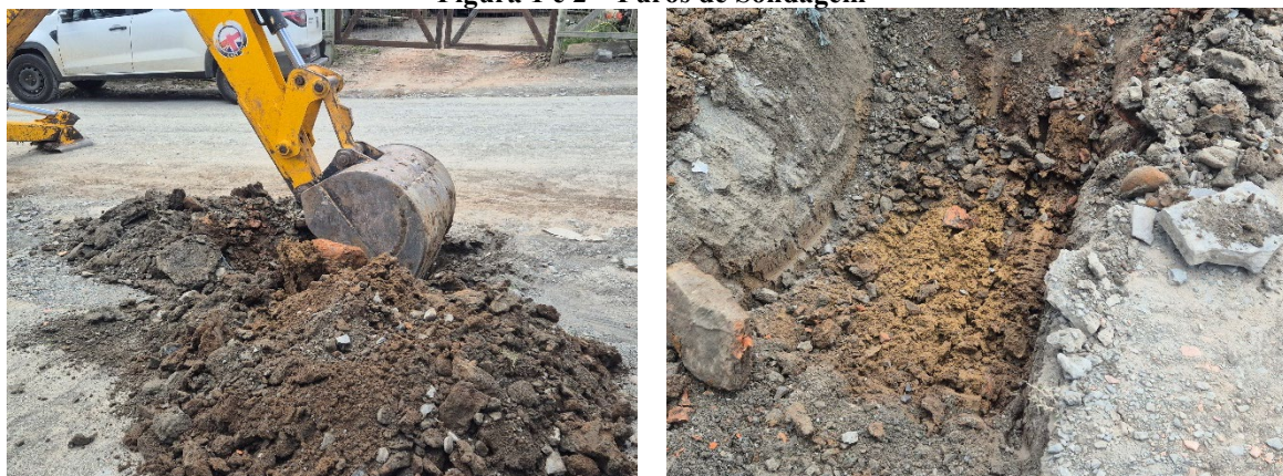
Figura 1 e 2 – Furos de Sondagem
