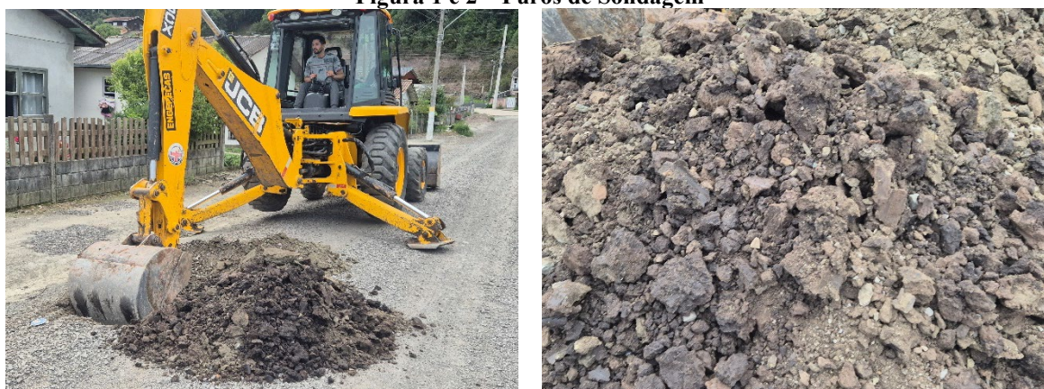
Figura 1 e 2 – Furos de Sondagem
