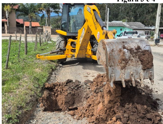
Figura 5 e 6 – Furos de Sondagem
