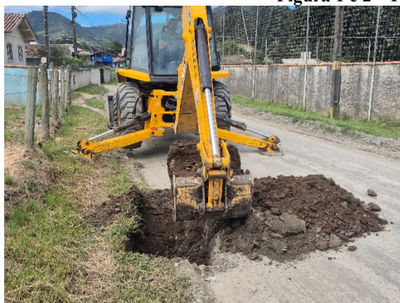
Figura 3 e 4 – Furos de Sondagem
