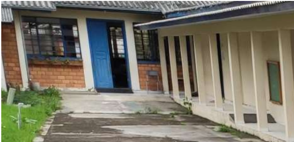
Rampa de Acesso
